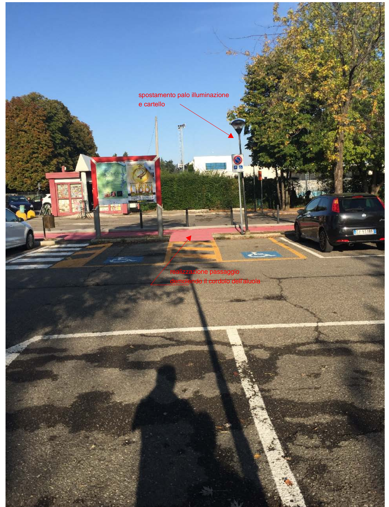
Parcheeggio scuola a. Ferrari - progetto - posti auto per disabili lo spazio di manovra permette di accedere direttamente al percorso pedonale dalla parte opposta dell'aiuola. con questa soluzione il disabile non è costretto a percorrere parte del parcheggio esponendosi al pericolo delle vettura in manovra.
